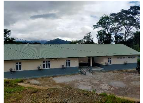
完成した母子保健病棟
